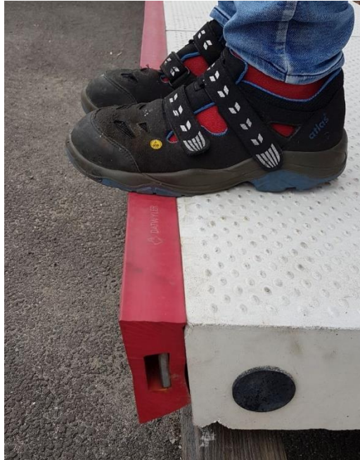
Bild 1: befestigte Gummikantenprofil an Bahnsteigkante
